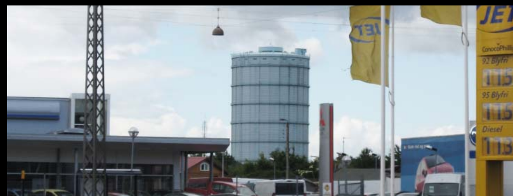
SILO VED TANKSTATIONEN PÅ ELLEBJERGVEJ
