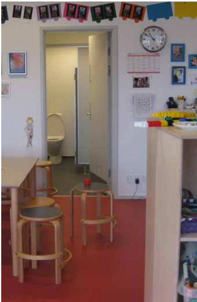
Lugtgener eller manglende mulighed for udluftning kan give dårlig luftkvalitet. Tænk over placeringen af f.eks. toiletter og skiftrum i forhold til andre funktioner. Definér hvor der er særlige krav til ventilation. Fotograf: Heidi Lund Hansen
