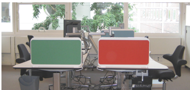
Lydabsorberende bordskærme og tæppegulv i kontorzone
