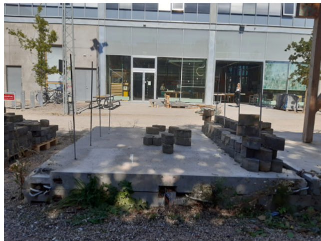
Fig. 9: Opmuring med SF-sten på fundamentsplatformen / Masonry with concrete pavement stones (SF stones)
