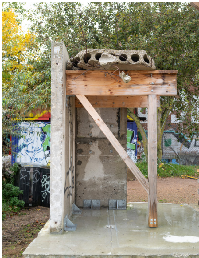
Fig 13: mockup-prototypen fra første iteration cirka et år efter den blev bygget. / The mock-up prototype from first iteration about one year after its construction.
