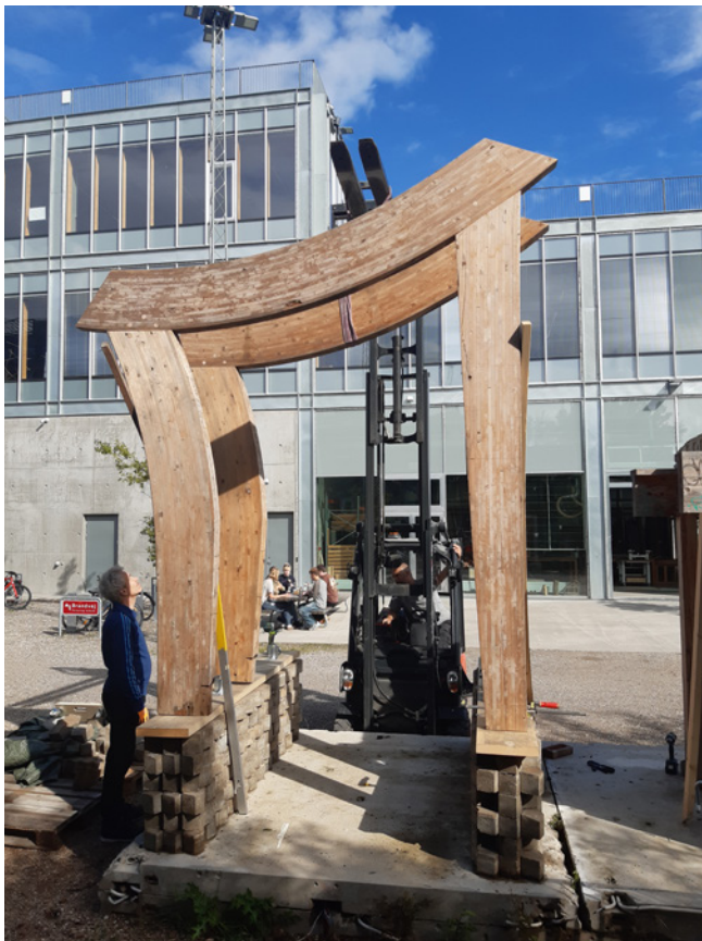
Fig. 10-11: Limtræsrammerne løftes på plads / The glulam frames are lifted into place
