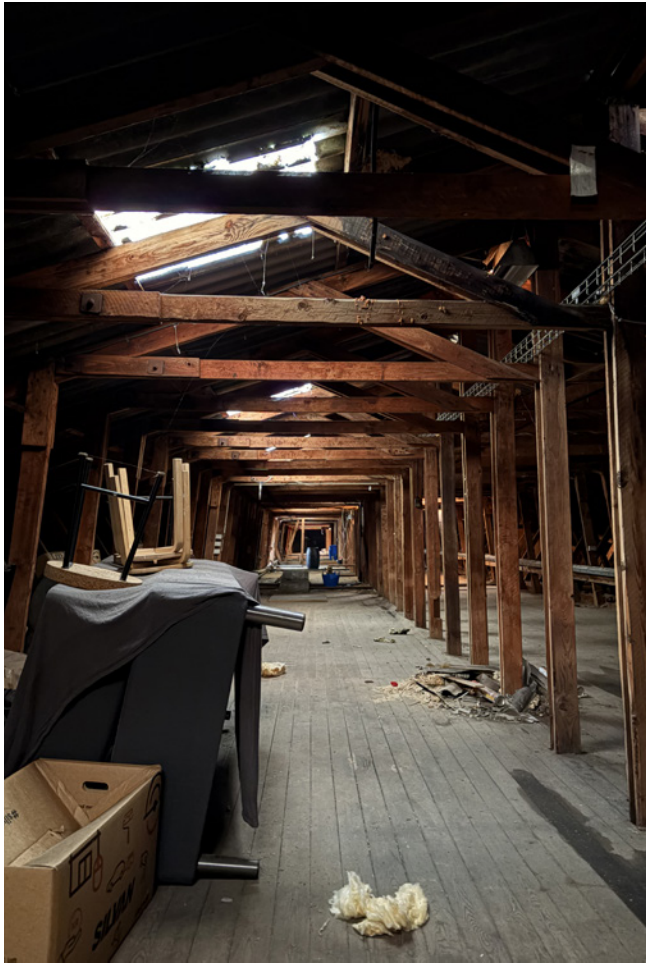
Fig 5: Tagkonstruktionen i bygning C1 / Timber roof structure of building C1
