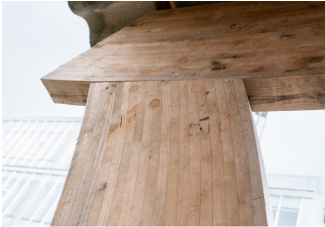
Fig. 13: Limtræsrammernes samling / Joints of the glulam frames
