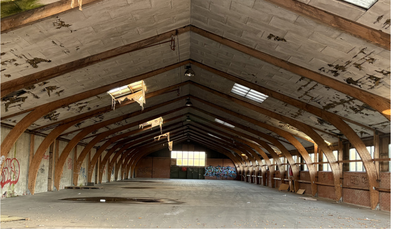
Fig 3: Lagerhallernes store spænd med limtræsspær /
