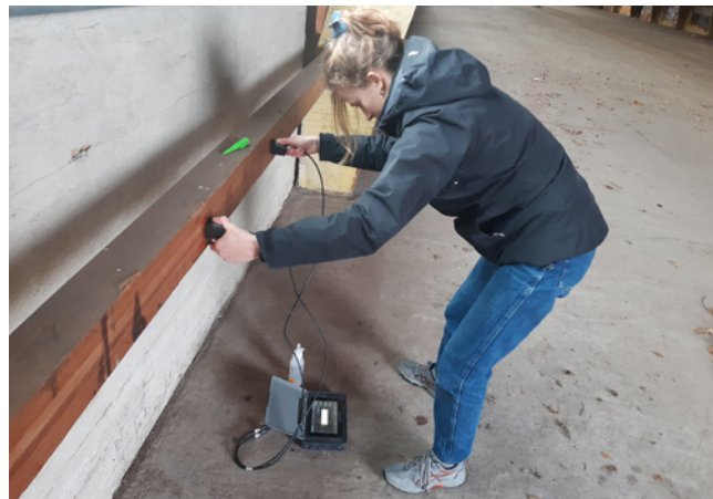
Fig. 7: Ultrasonic Pulse Echo, Listefabrikken, Åbyhøj
