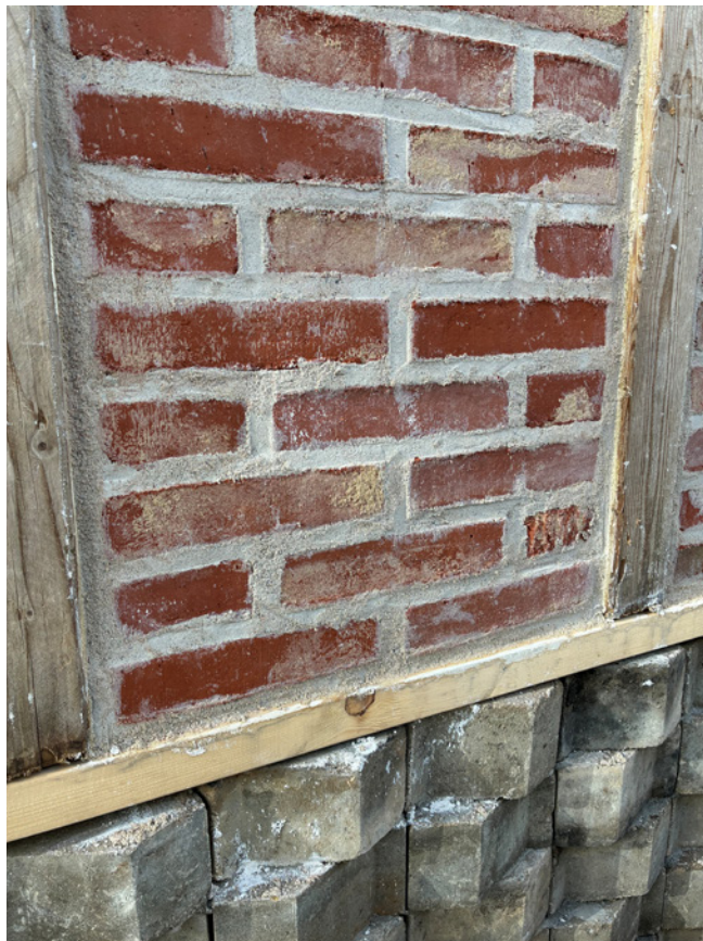
Fig. 15-17: Genbrugsgaver, fundet i Listefabrikken, Åbyhøj, og oparbejdet til nyt byggeri, forslag fra SLETH, Anna Mette Exner Arkitektur, Arkitema, EFFEKT, CEBRA, JJW. / 'Reuse gifts', found in Listefabrikken, Åbyhøj, and reworked for new construction, proposal by SLETH, Anna Mette Exner Arkitektur, Arkitema, EFFEKT, CEBRA, JJW arkitekter.
