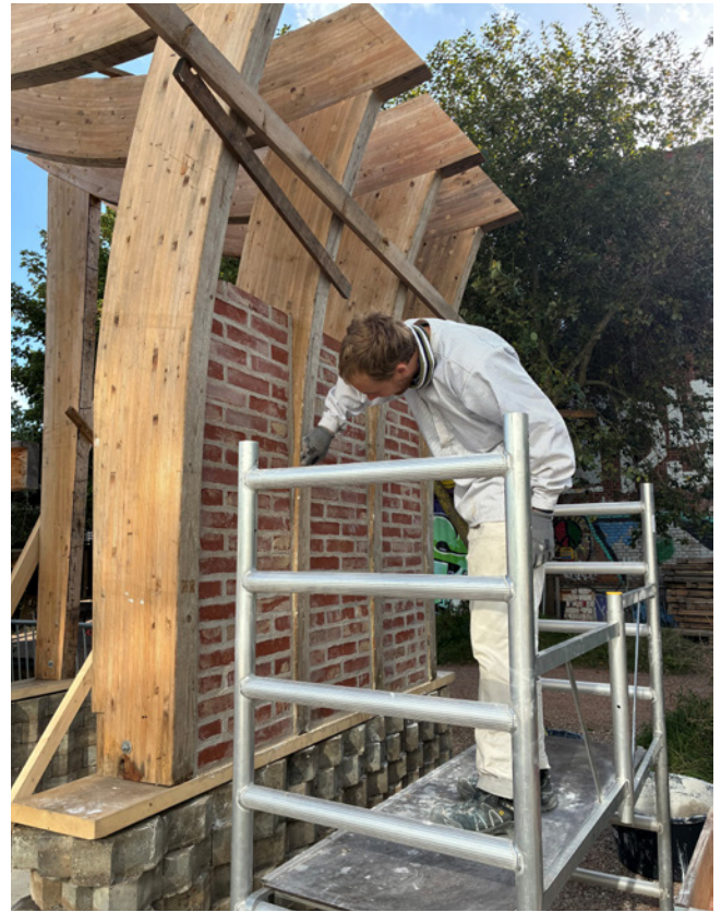
Fig. 12: Arkitekt og murer Lasse Buus arbejdede med opmuring med genbrugte mursten mellem limtræsrammerne / Architect and bricklayer Lasse Buus working on the infill masonry using reused bricks
